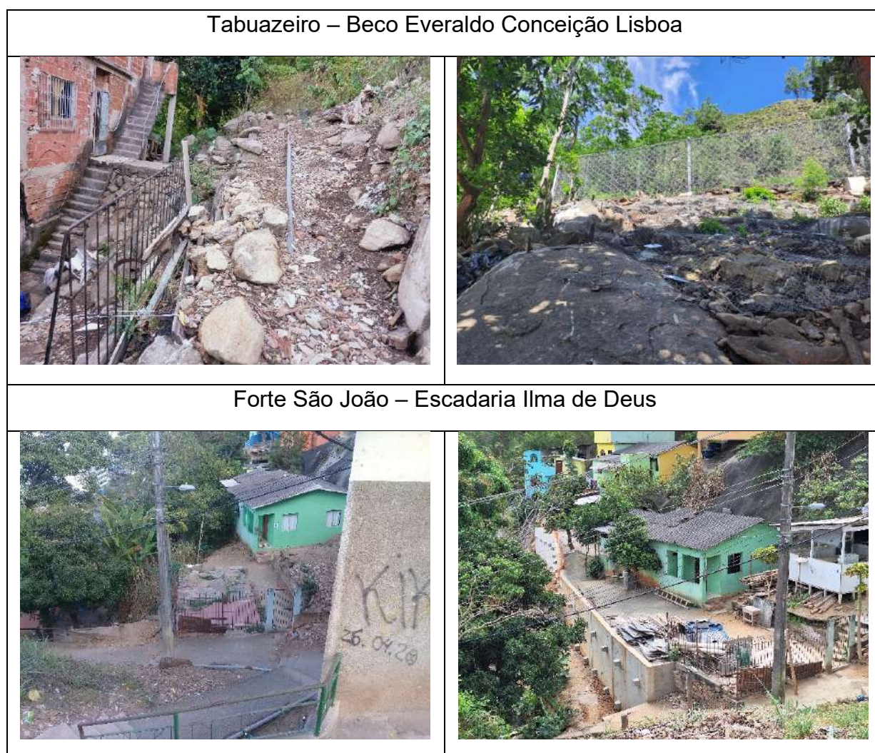
Figura 26 - Antes e depois de algumas obras executadas em 2024.
